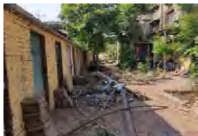
桥南小区改造前
