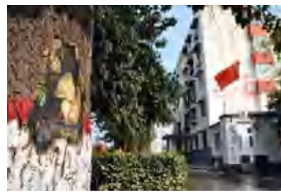
桥南小区改造后
