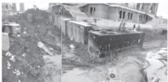
图 3 地源热泵检查井现场实施场景
