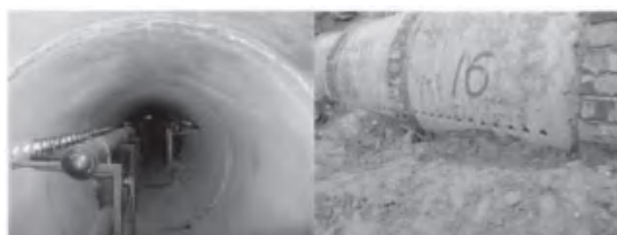
图 6 预制水泥管检查井现场实施场景
